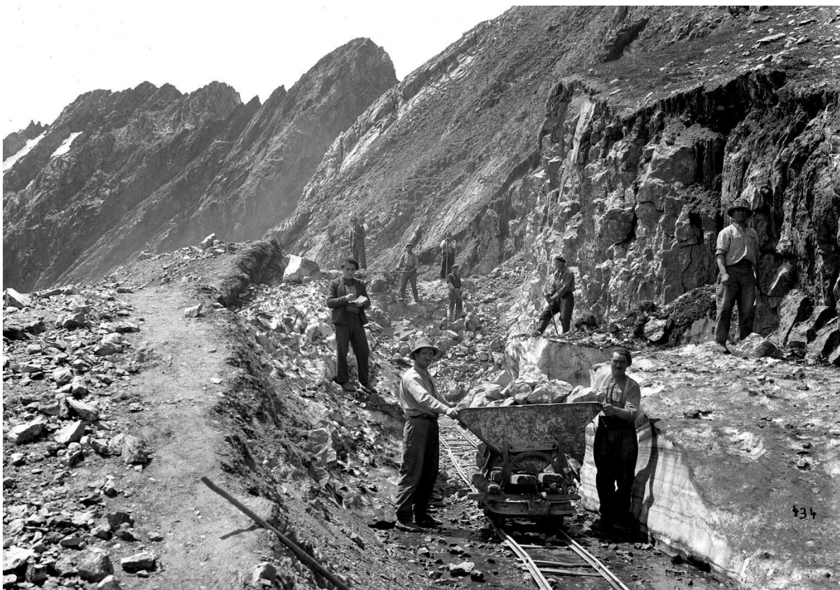
Construction de la route du Pic du Midi – 8 juillet 1933 – Archives Fond Eyssalet, Bagnères de Bigorre
